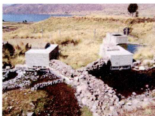
Requiere limpieza vegetación, reparar puerta, tubería de salida y candado
