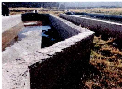
Deterioro de tarrajados del estanque
