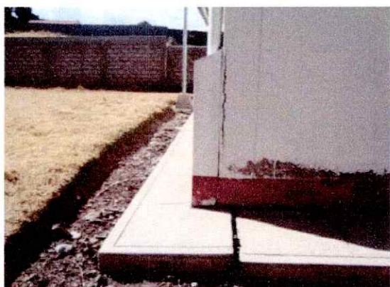
Hundimiento de veredas
