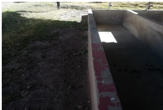
Deterioro de tarrajados del estanque
