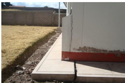
Hundimiento de veredas
