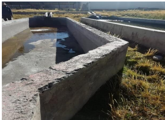
Deterioro de tarrajados del estanque
