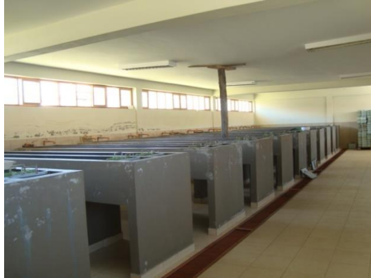
Por problemas estructurales del techo, Hundimiento del cielo raso
