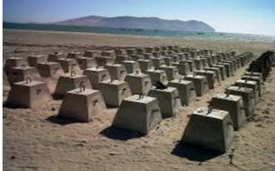
Figura 42. Construcción de lastres
