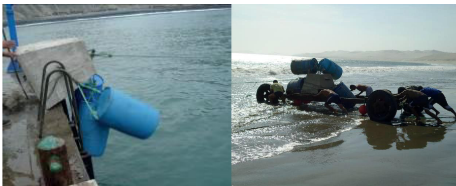
Figura 49. Maniobras para la adecuada instalación de los anclajes
