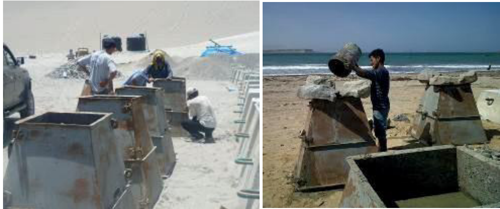
Figura 12. Armado de moldes y vaciado de concreto para lastres
