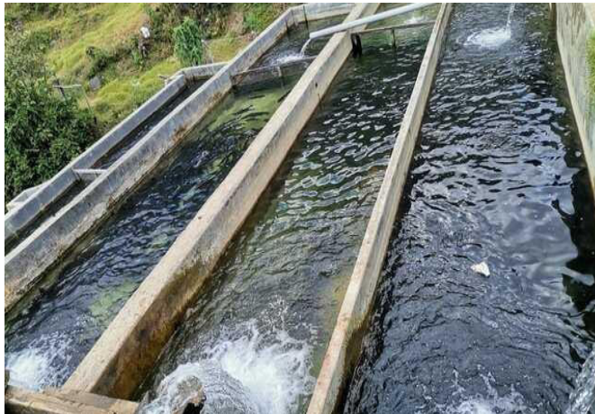
Figura 3. Estanque de concreto
