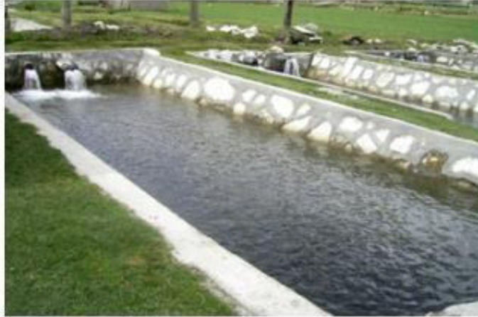
Figura 4. Estanque de mampostería
