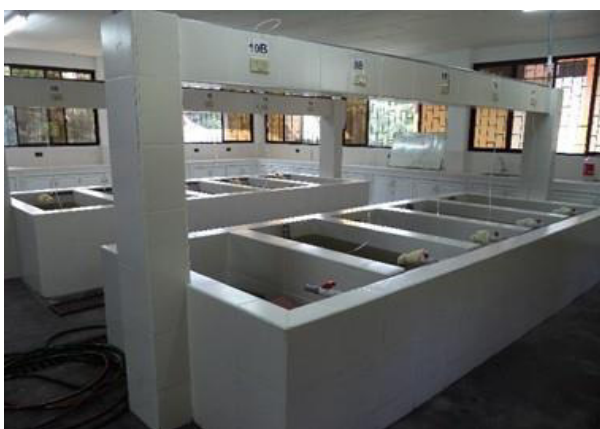
Figura 3. Sistema de tanques de concreto para seleccion y manejo de reproductores, larvas, post-larvas y alevinos
