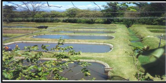
Tilapia: Estanques cementados
