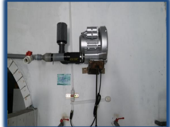
Blower/aireador instalado en Módulo
