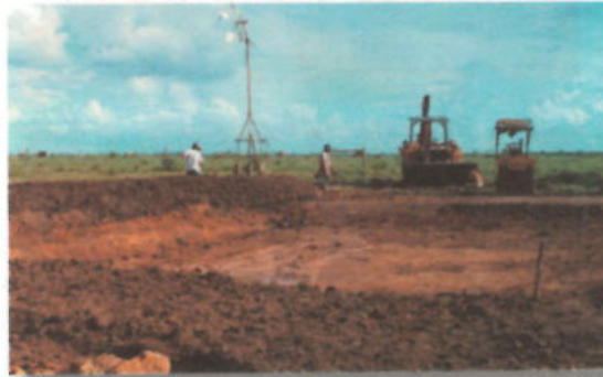
Figura 11. Conformación de las paredes de los estanques.
