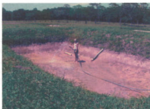
Figura 16. Estanque limpiado y en proceso de desinfección.
