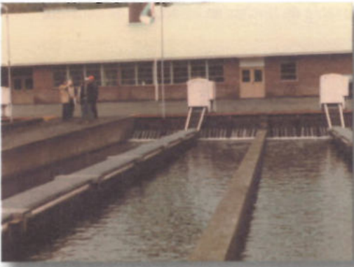
Figura 28. Estanques en cemento.
