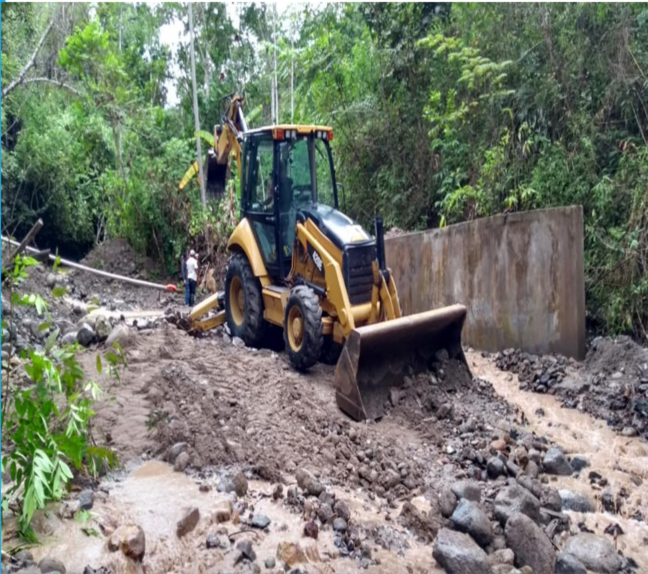
Bocatoma del Modulo Piscícola la Balsa Colmatada
