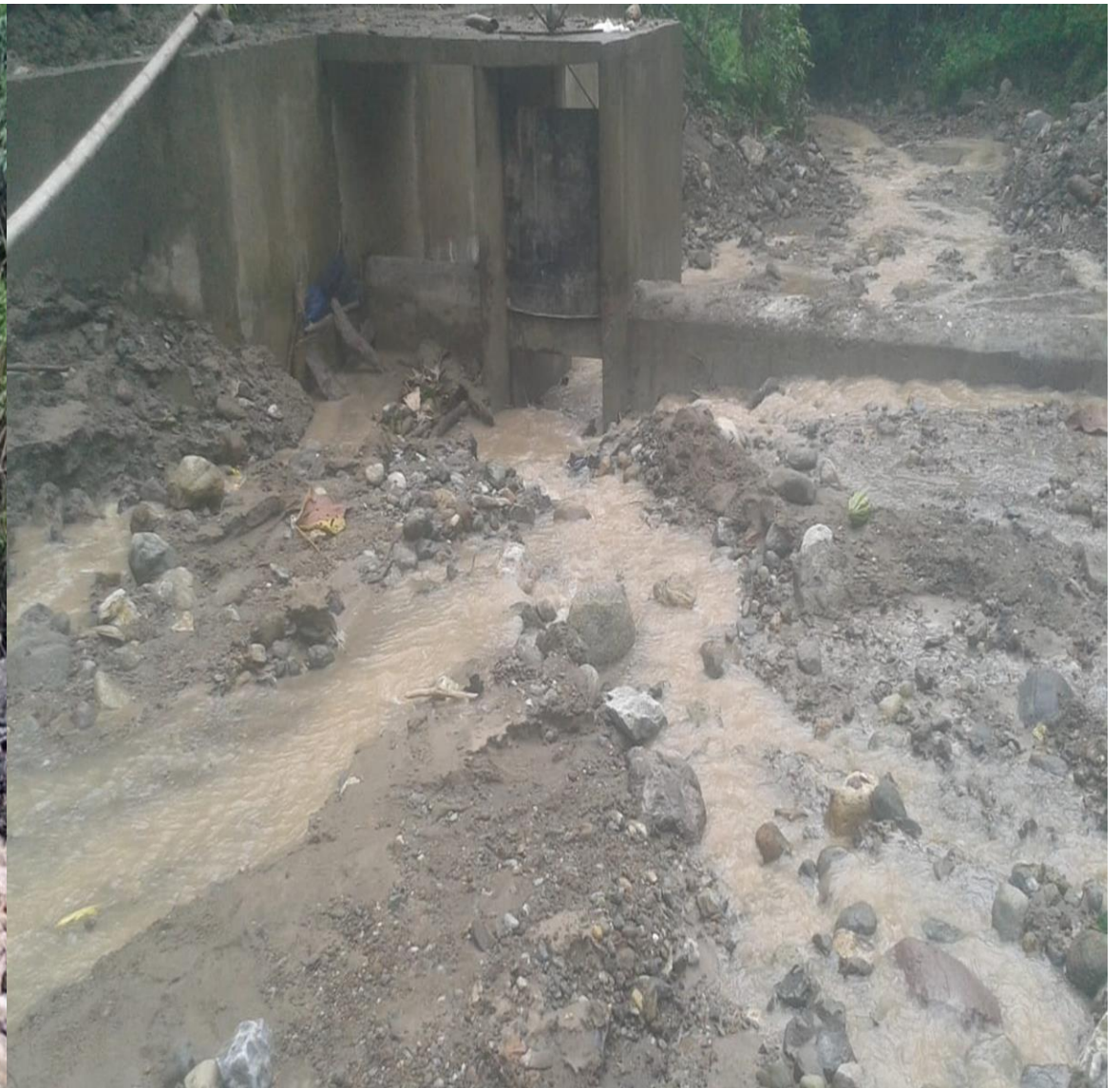
Bocatoma del Modulo Piscícola la Balsa Colmatada
