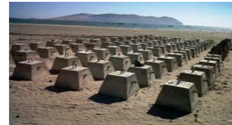
Figura N° 19: Construcción de lastres (FONDEPES-OSPAS Región Ica, 2012)
