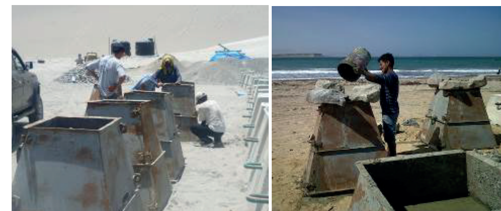
Figura N° 22: Armado de moldes y vaciado de concreto para lastres (FONDEPES-OSPAS –Región Ica, 2012)
