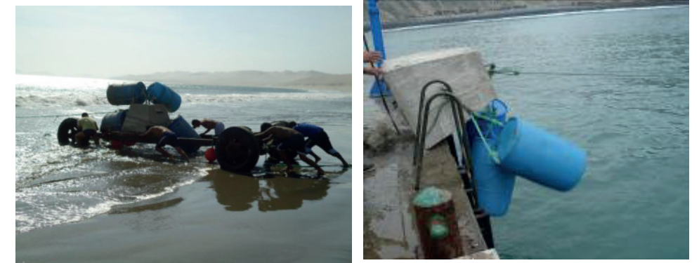
Figura N° 26: Maniobras para la adecuada instalación de los anclajes
