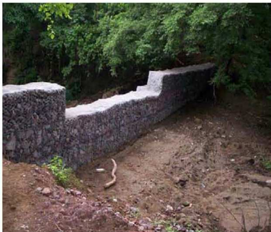
Ejemplo de sistemas de retención de sedimentos
