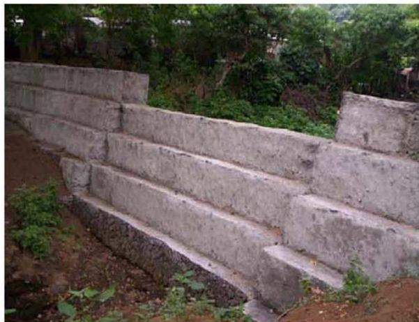
Ejemplo de dissipador de energía de las corrientes de agua
