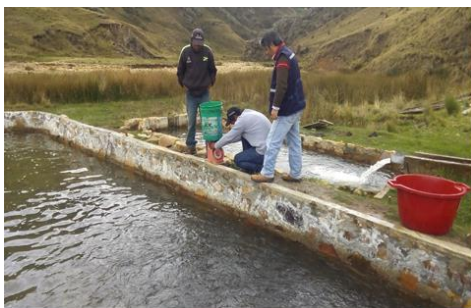
Fotos N° 3 y 4: Estanques de mampostería de piedra
