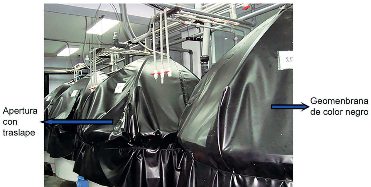
Figura 5. Parte externa de tanque de cultivo, presentando: geomembrana de color negro y abertura con traslape.
