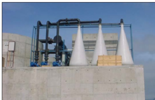
Fig. N° 32: Sistema de oxigenación de conos de sobresaturación
