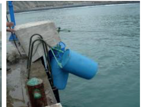
Figura N° 26: Maniobras para la adecuada instalación de los anclajes
