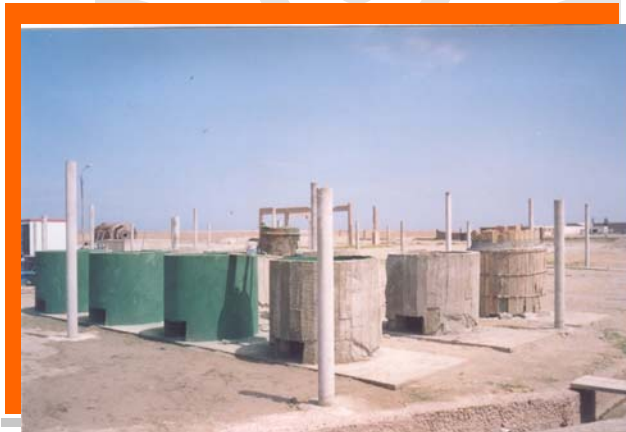
Estanques de concreto para la reversión sexual
