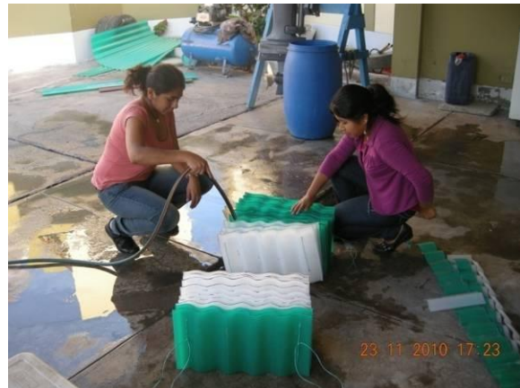
Figura 34. Limpieza de placas antes de su instalación
