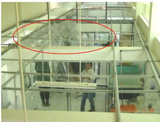
Figuras 1 y 2. Proceso de instalación de techo temporal (plastificado) en la sala de larvas del LIM
