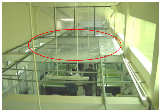
Figuras 1 y 2. Proceso de instalación de techo temporal (plastificado) en la sala de larvas del LIM
