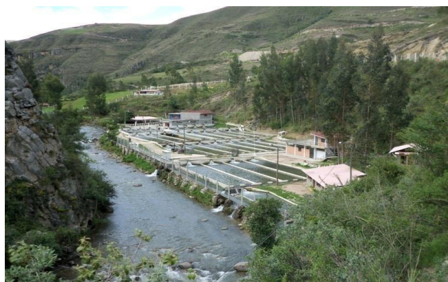
Figura N°5: Piscigranja El Chano - La Encañada con estanques de concreto armado.
