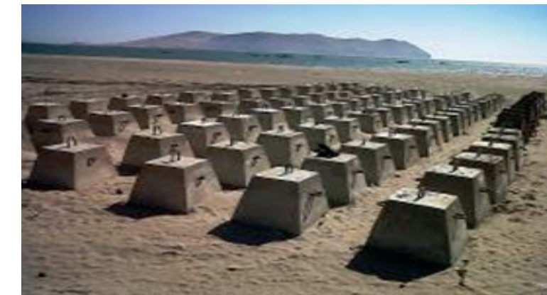
Figura N° 19: Construcción de lastres (FONDEPES-OSPAS Región Ica, 2012)
