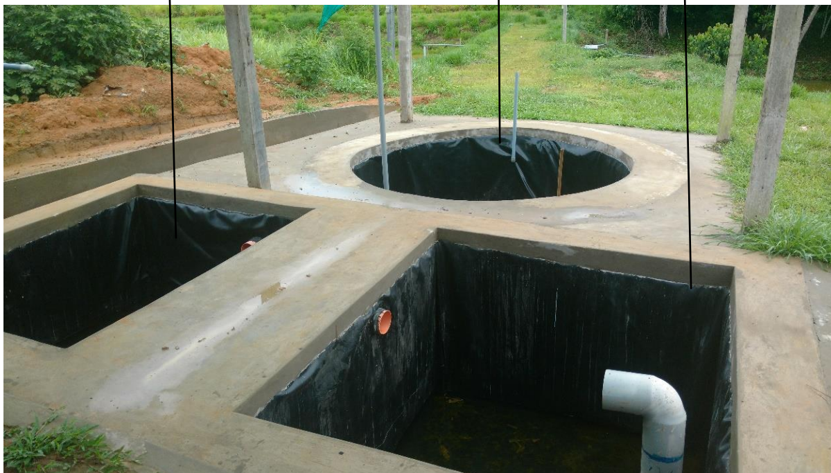
Biofiltro (2) Tanque Compensación (3) Mineralizador (1) FIG 52 MINERALIZADOR-BIOFILTRO-SUMIDERO
