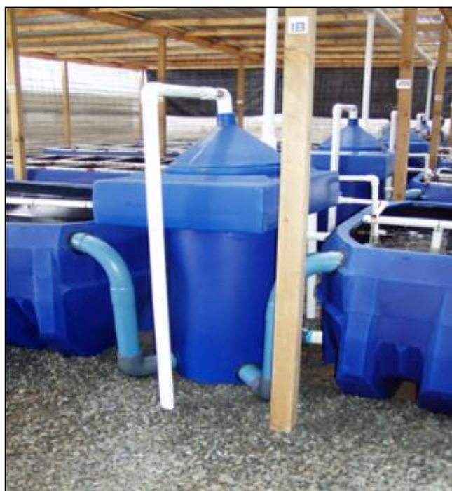
FIG 26 FRACCIONADOR DE ESPUMA
